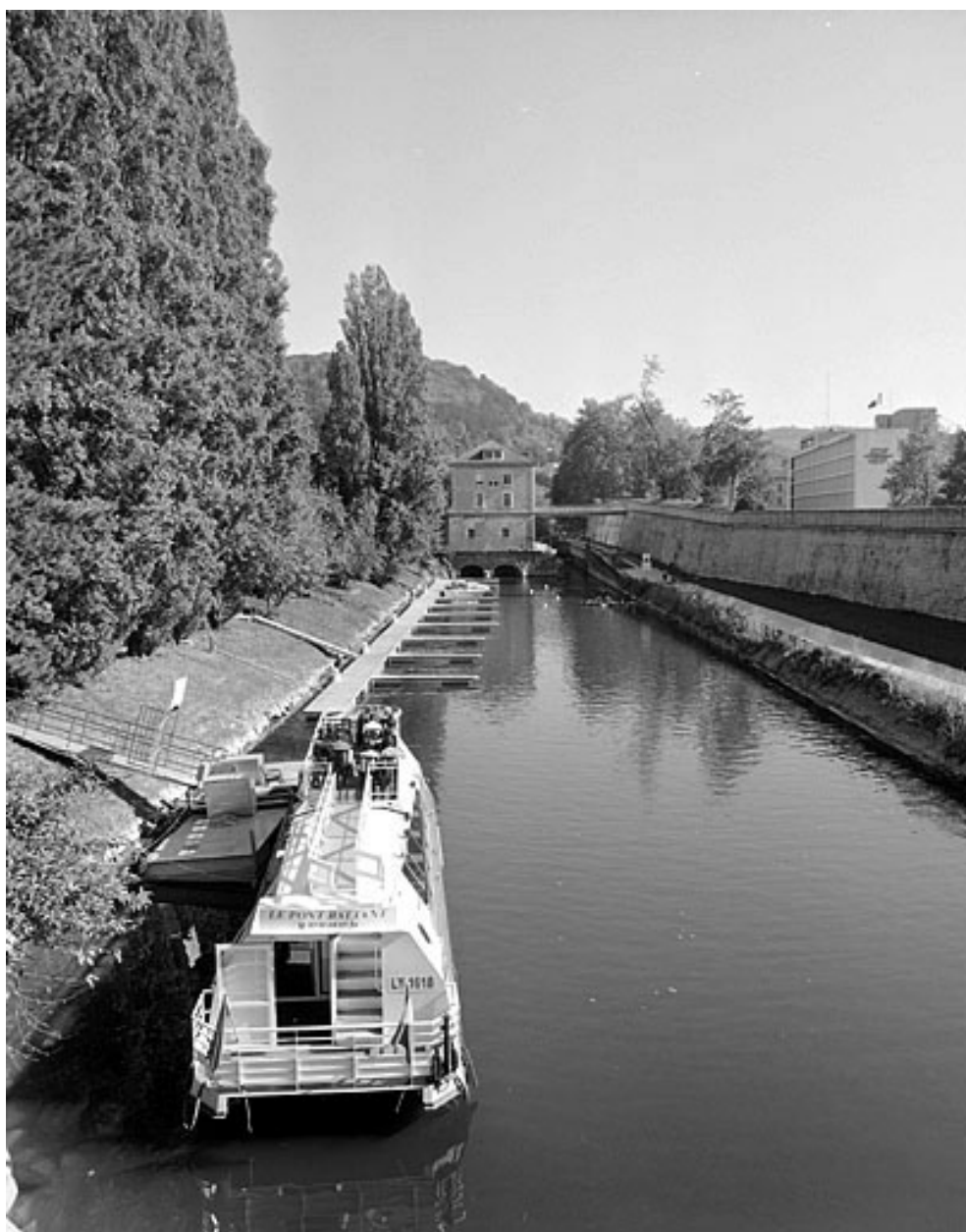
Vue d'ensemble du moulin Saint-Paul, depuis l'aval.
