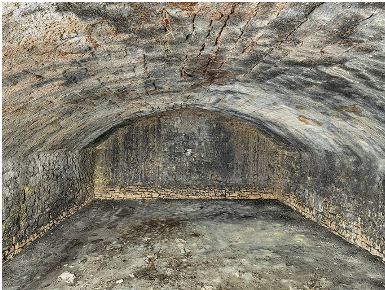
Autre casemate du niveau inférieur.
