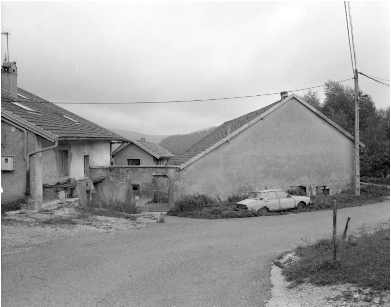
Vue générale de l'accès à la maison.
