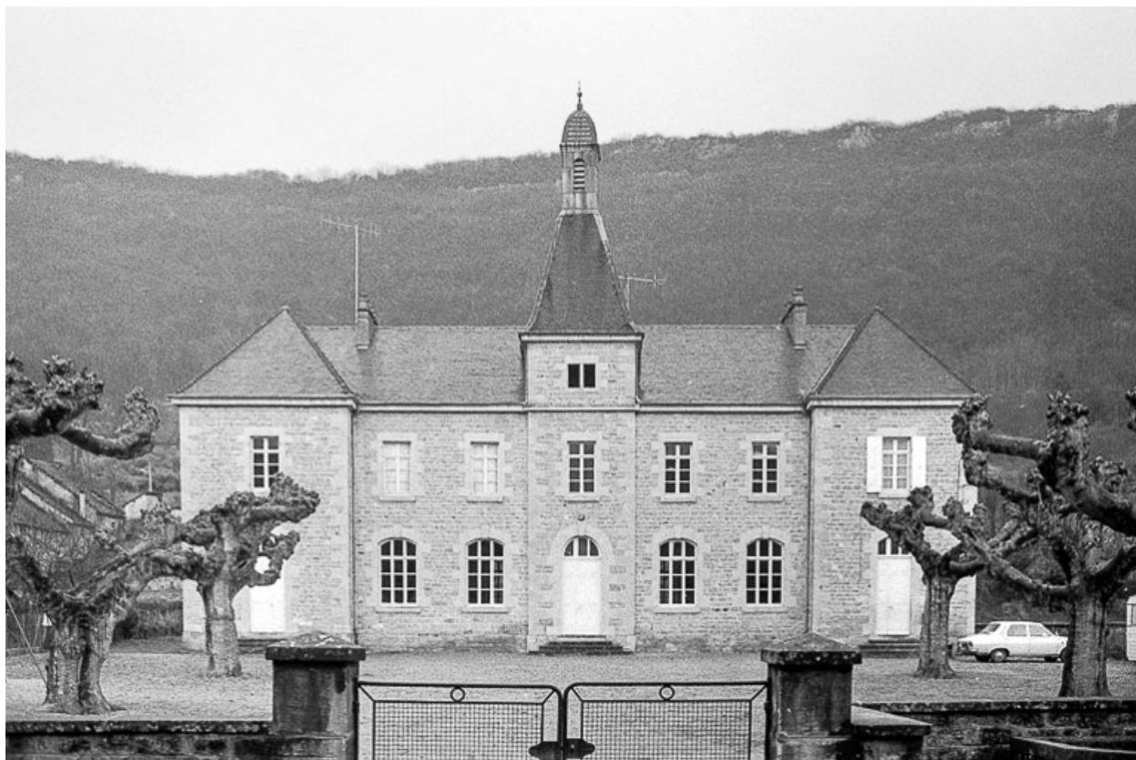
Mairie-école : façade antérieure.
