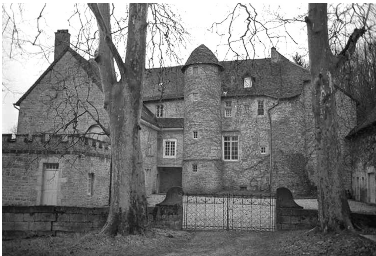
Façade sur cour et portail d'entrée.
