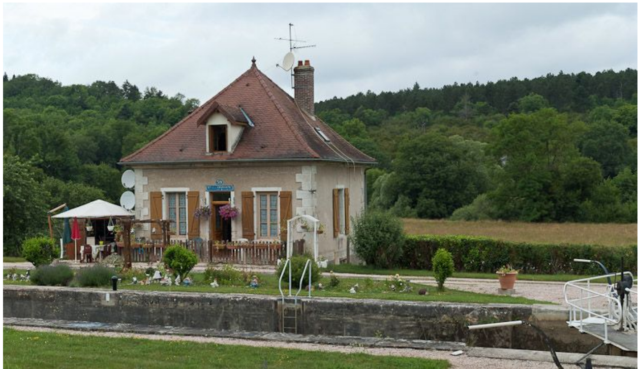
Vue de face de la maison éclusière.
