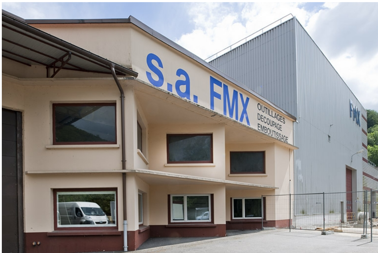
Façade nord : le nouvel atelier des presses.
