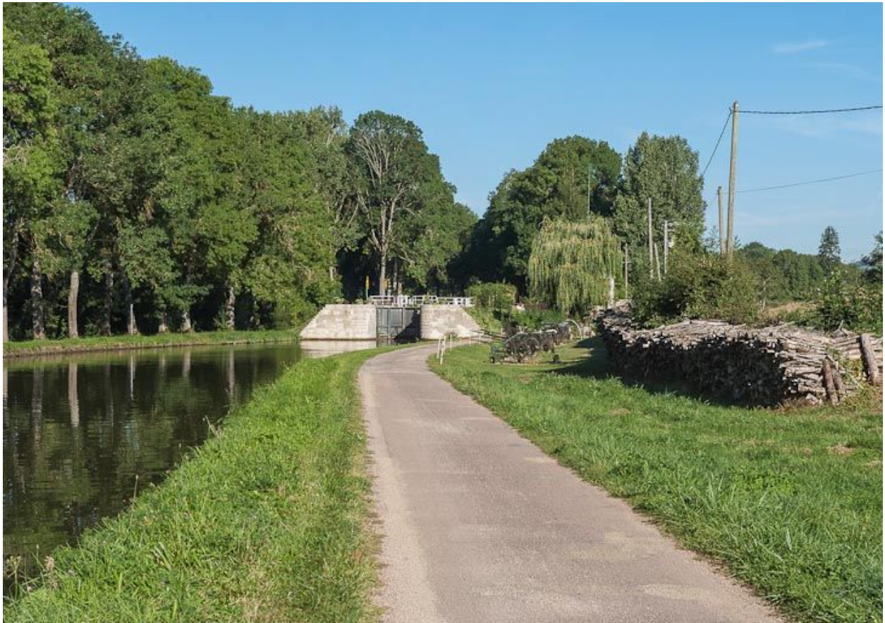
Vue de l'écluse depuis l'aval.
