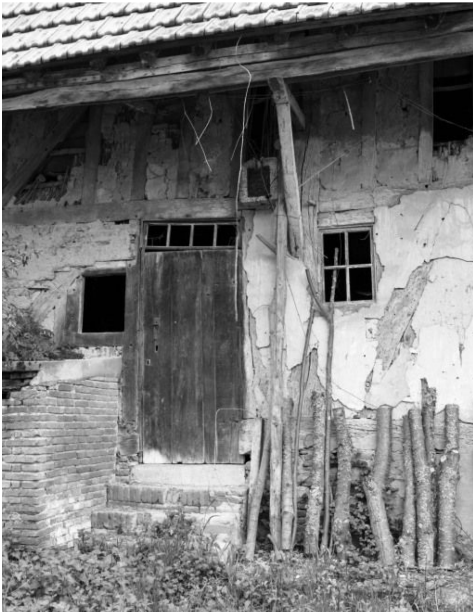
Façade du logis, détail.
