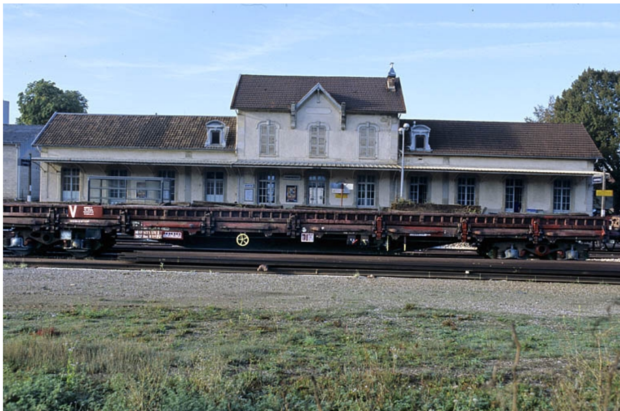
Bâtiment des voyageurs : façade postérieure.
