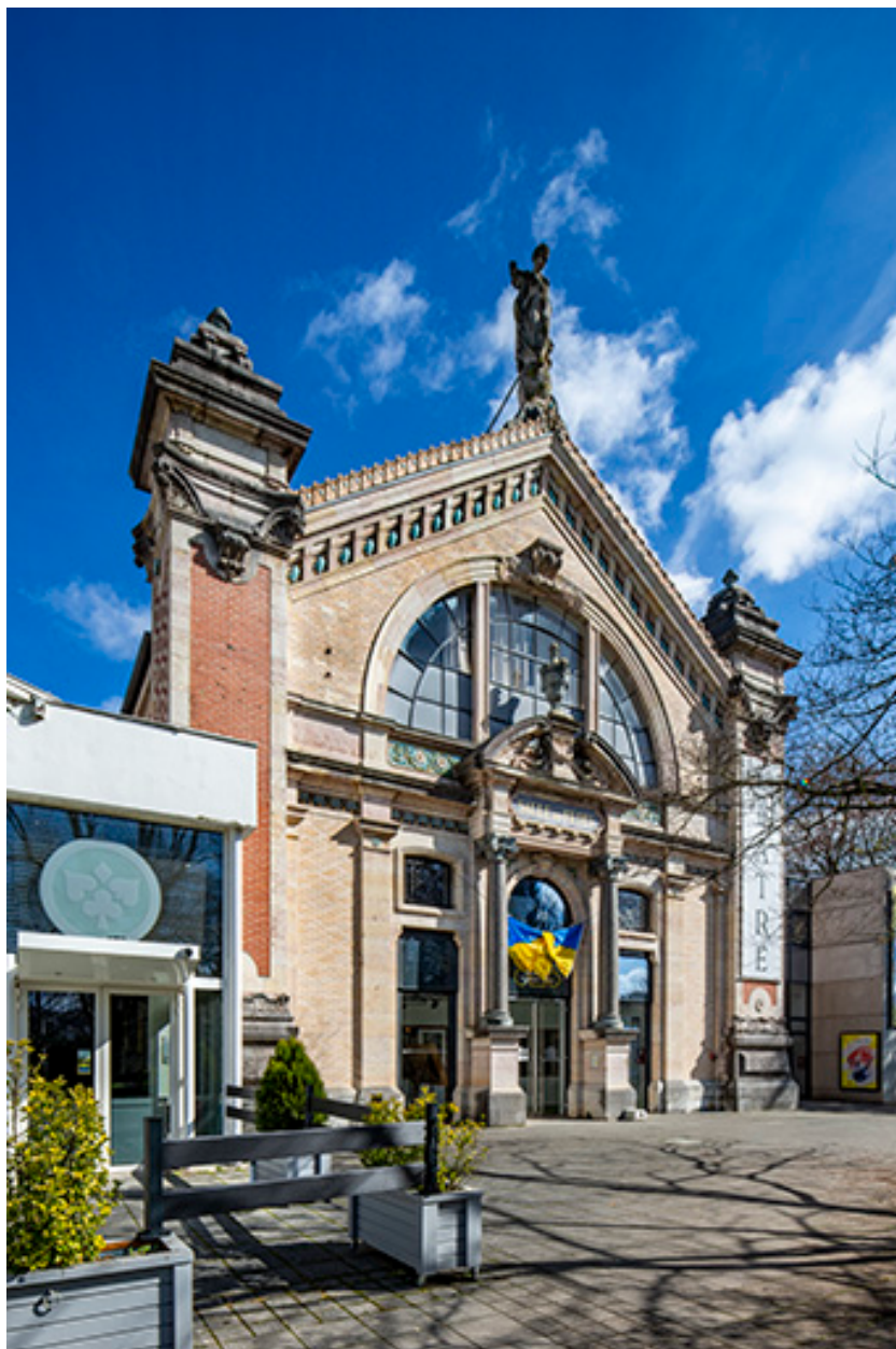
Façade principale, vue de trois quarts.
