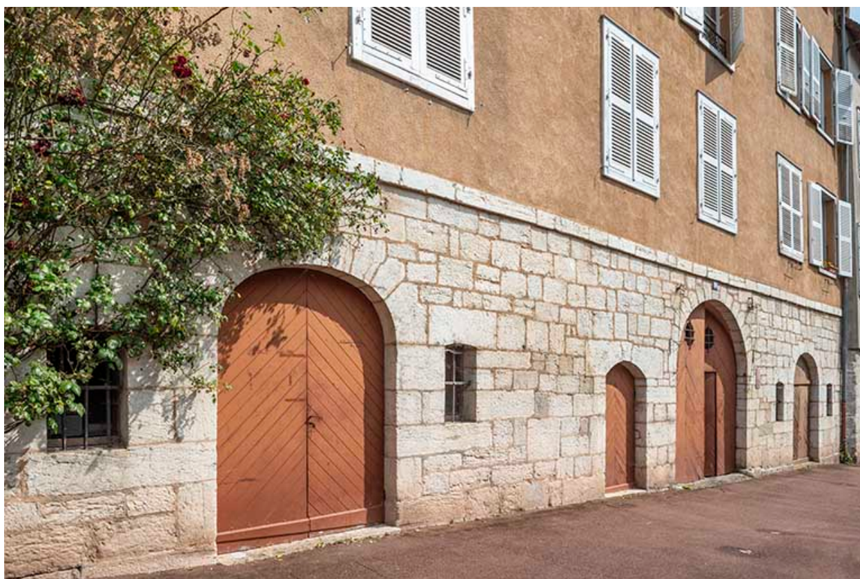
Les ouvertures au rez-de-chaussée.
