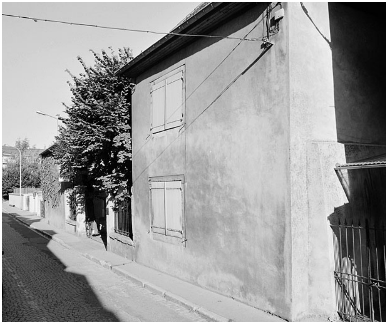
Vue d'ensemble prise de la rue de Belfort.
