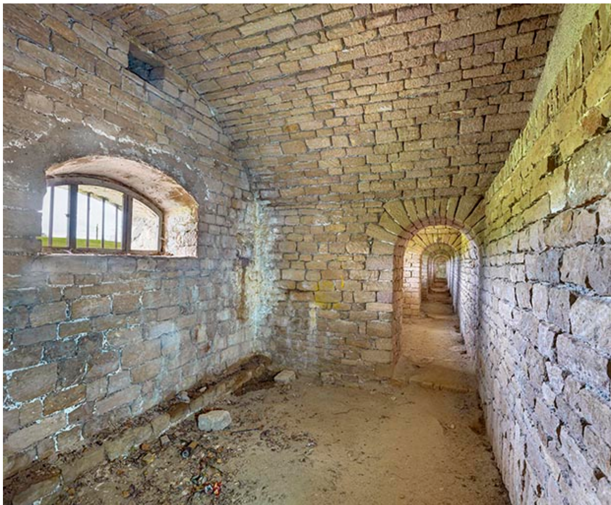
Galerie intérieure de la courtine.
