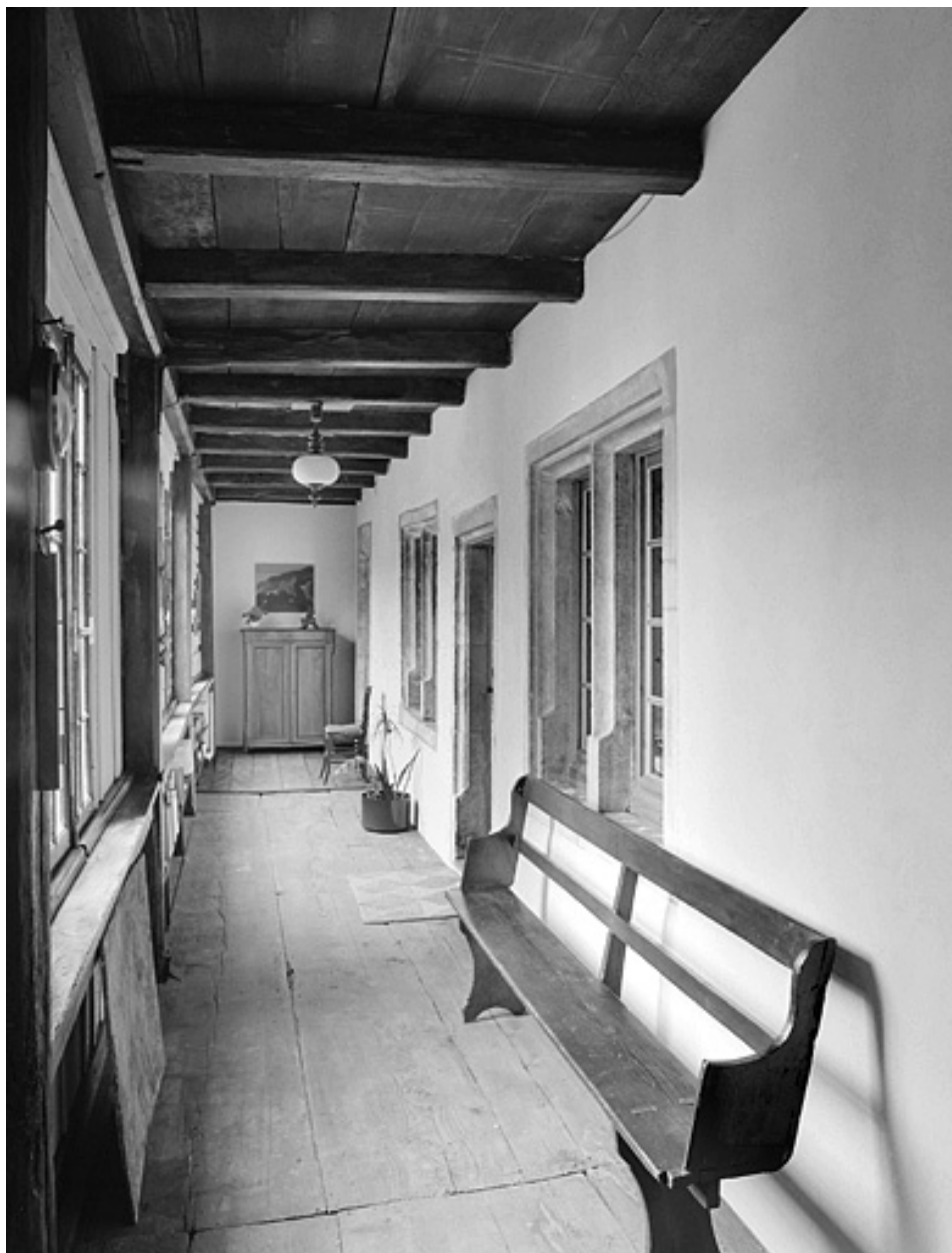
Galerie de distribution du premier étage.
