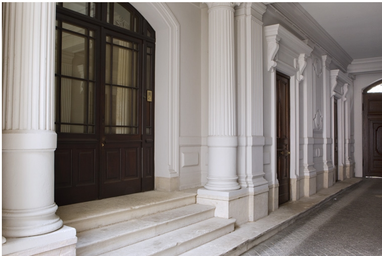
Passage cocher :détail du mur droit.
