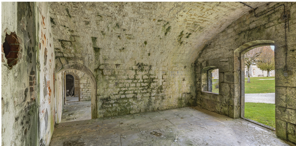
Fort Saint-André : pièce casematée.
