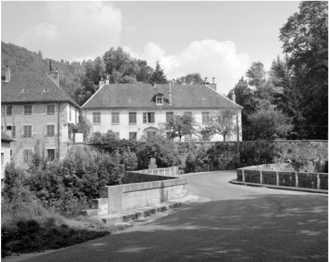
Façade antérieure depuis le pont.
