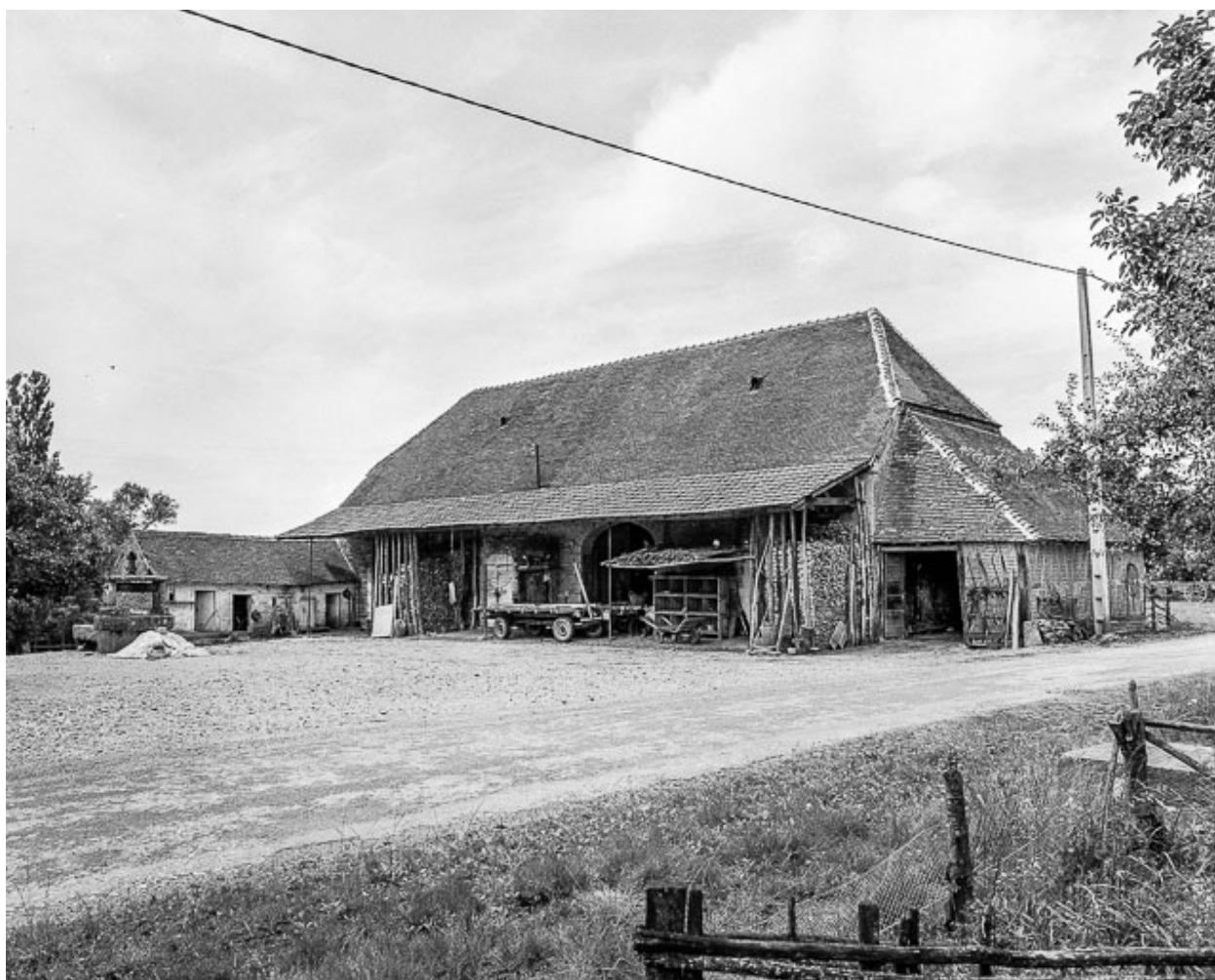
Le bâtiment d'exploitation.
