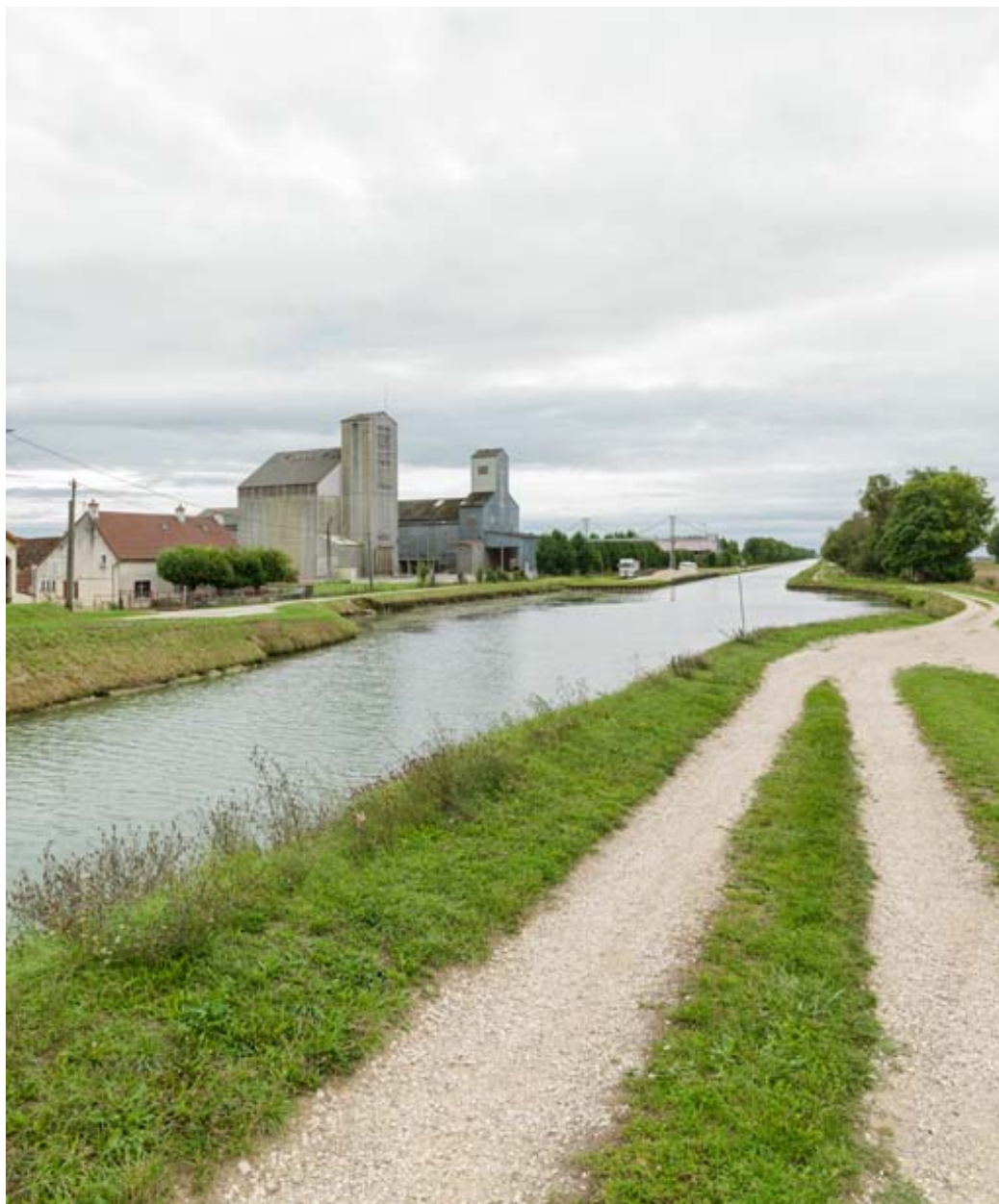
Vue d'ensemble de la gare d'eau.
