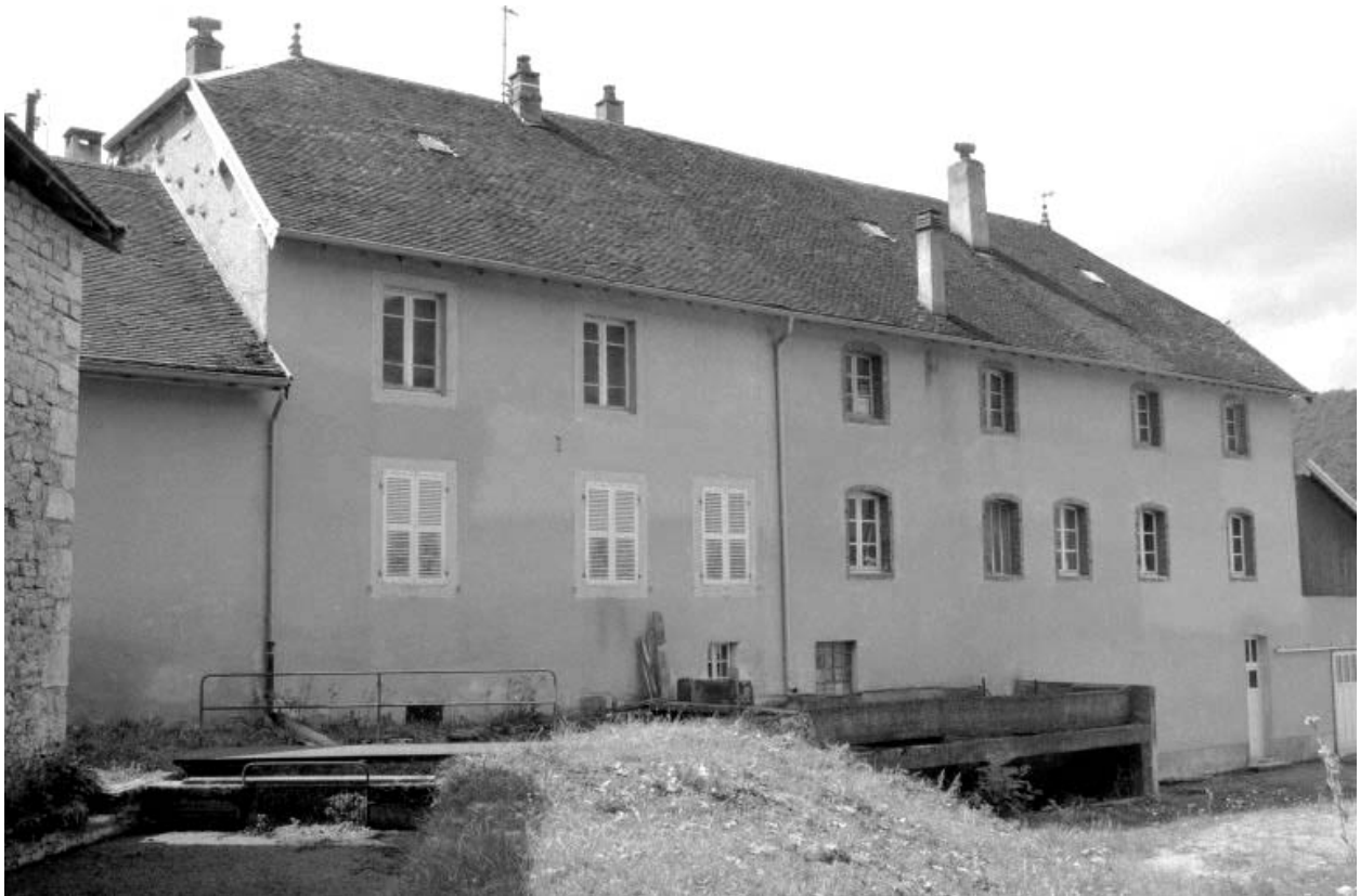
Façade postérieure du premier atelier de fabrication.
