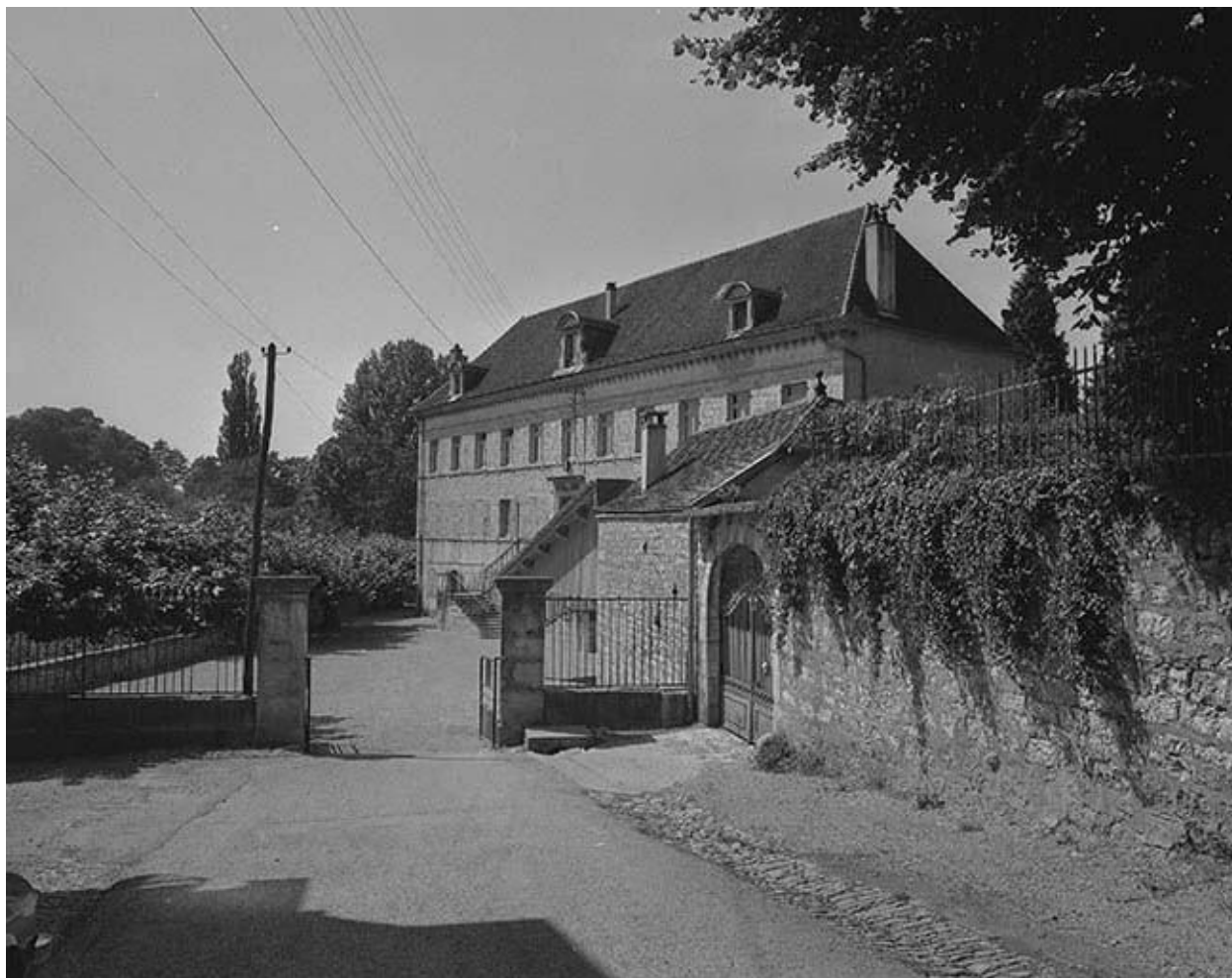
Vue générale depuis l'entrée de la cour.
