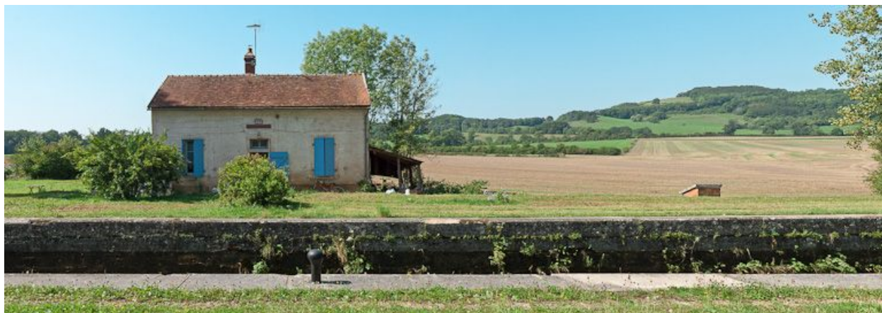
Vue de face de la maison éclusière.
