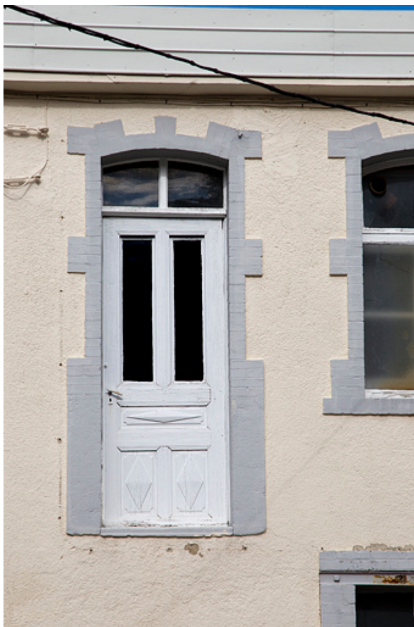
Atelier rehaussé en 1923-1924 : porte haute.
