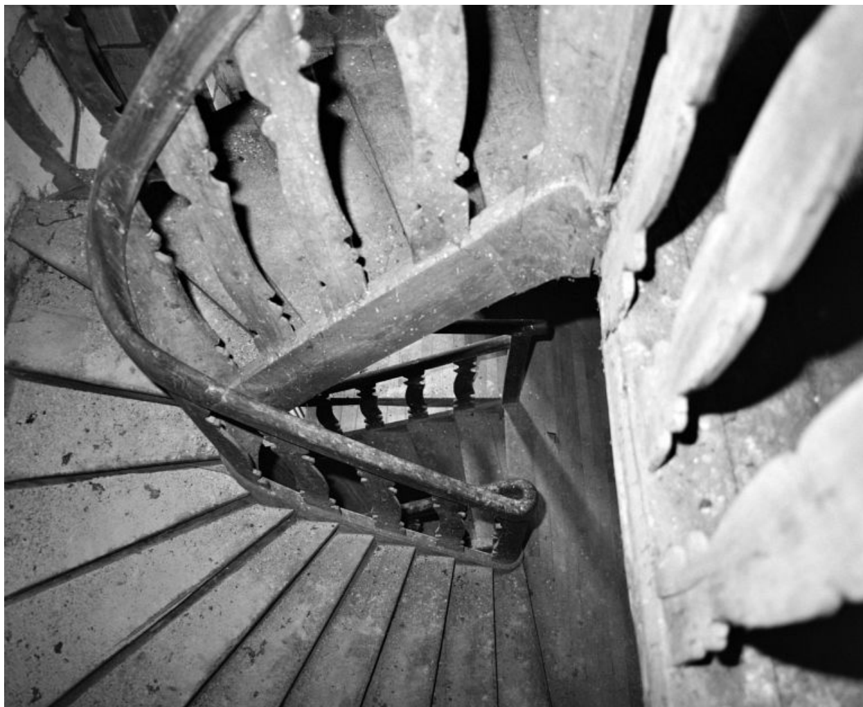
2e étage. Escalier, détail.
