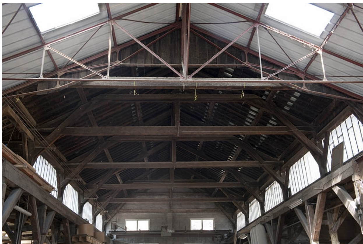
Halle de fonderie. La charpente.
