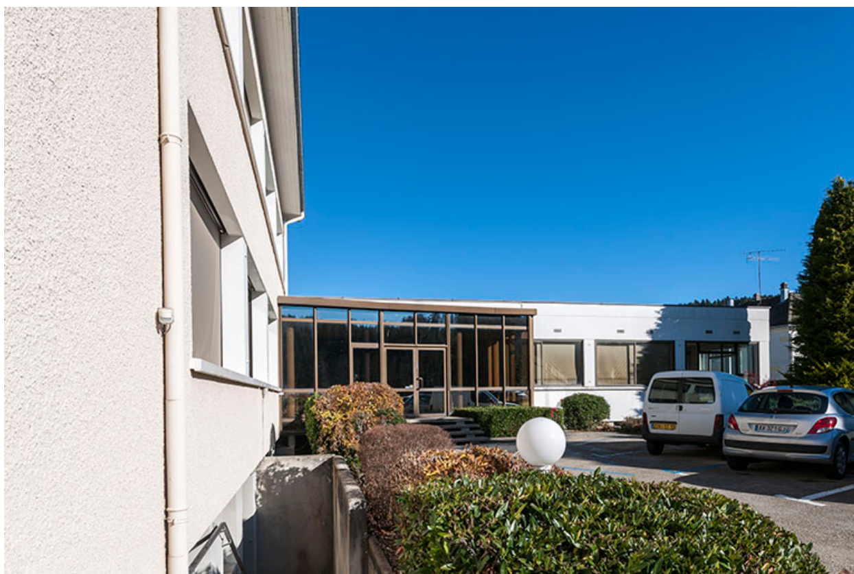
Façade antérieure : corps en retrait, à l'est.
