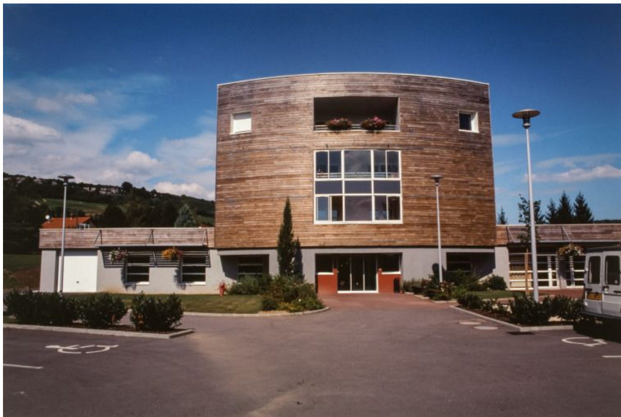
Maison de retraite, élévation antérieure.
