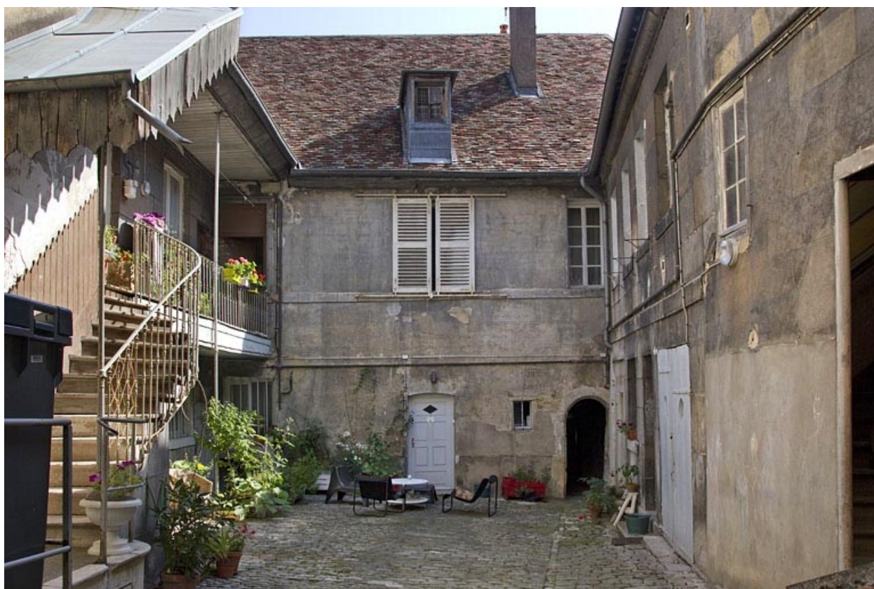
Premier logis secondaire : vue d'ensemble, de face.
