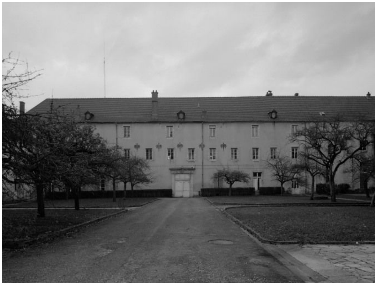
Bâtiment conventuel : façade.
