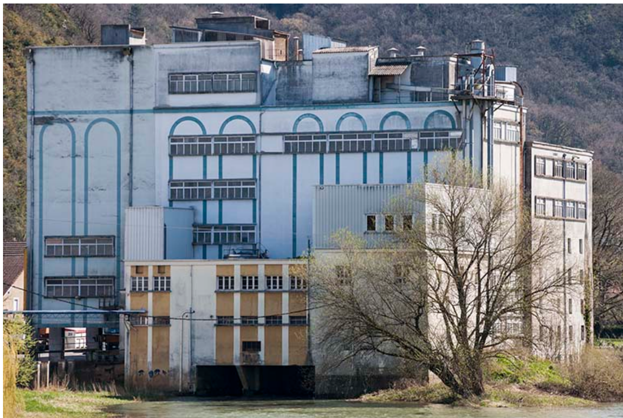
Vue rapprochée, depuis le sud-ouest.
