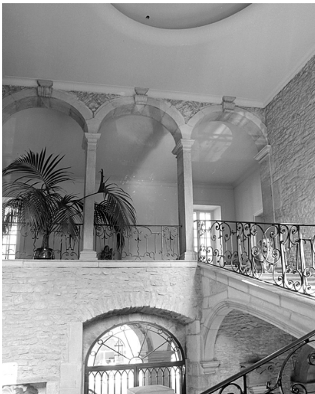
Bâtiments conventuels. Escalier : dernière volée et palier.
