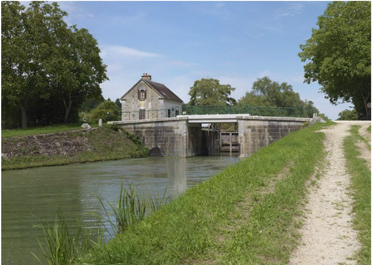
Le pont vu d'aval.
