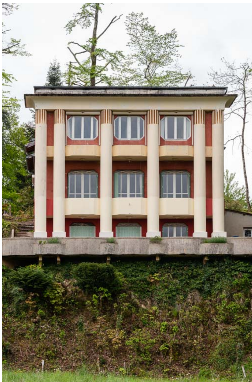
Façade nord, vue de face.
