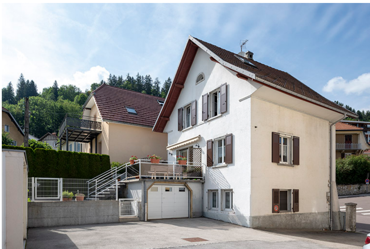
Façades postérieure et latérale gauche.
