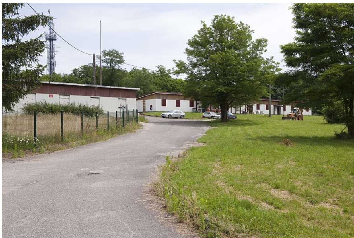
Logements N et L vus depuis l'ouest.
