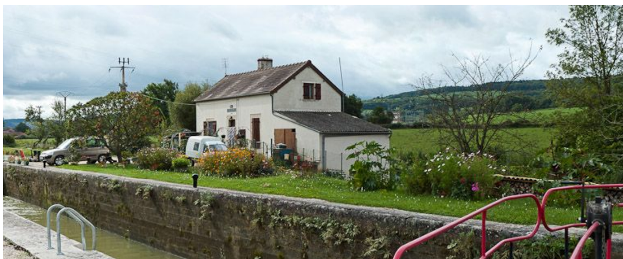
Vue d'ensemble du site d'écluse.
