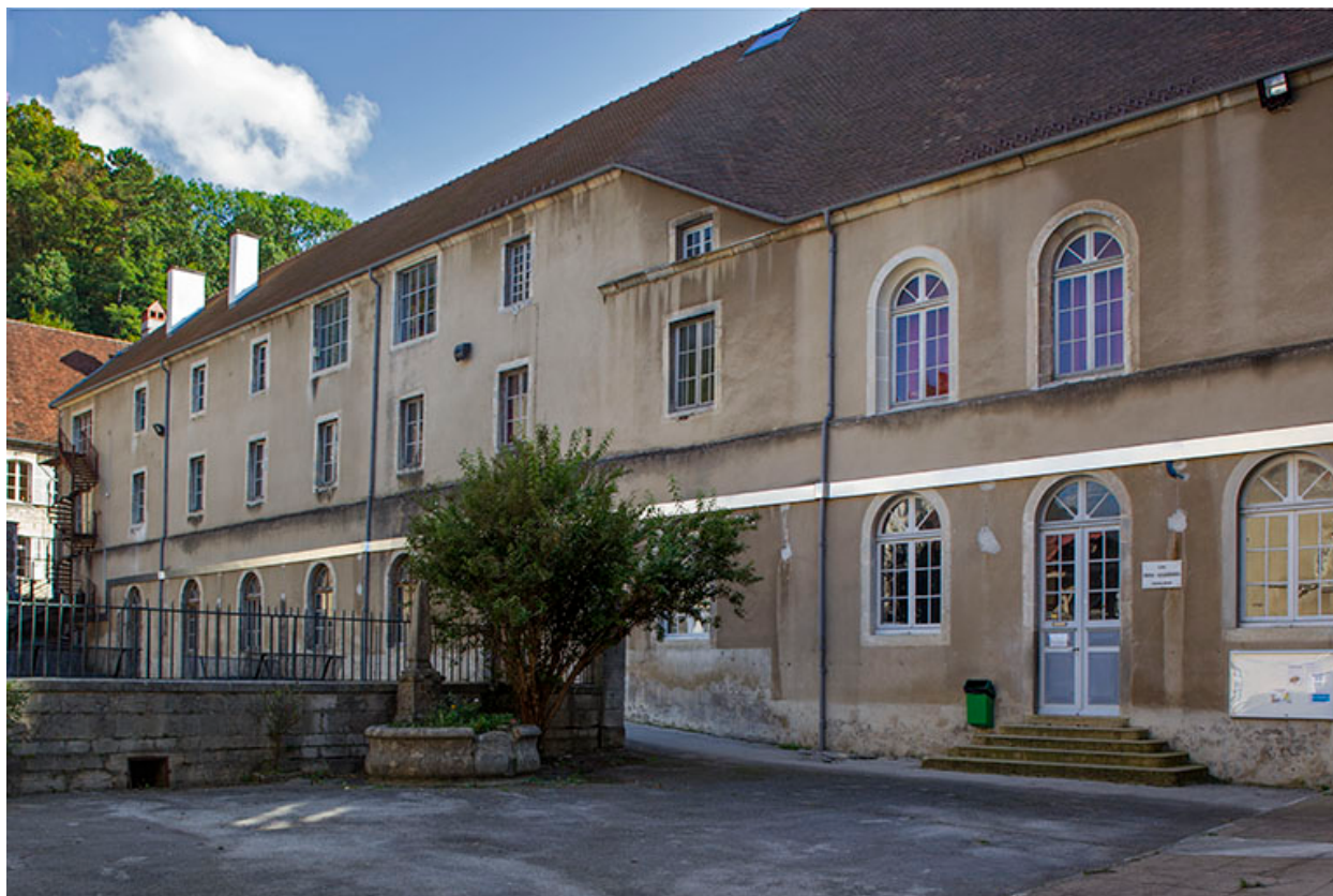
Site des oratoriens : façades sur cour.
