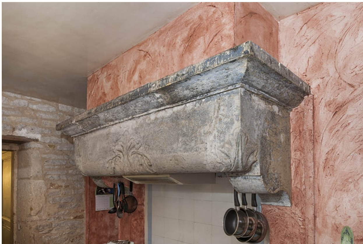
Cheminée de la cuisine.
