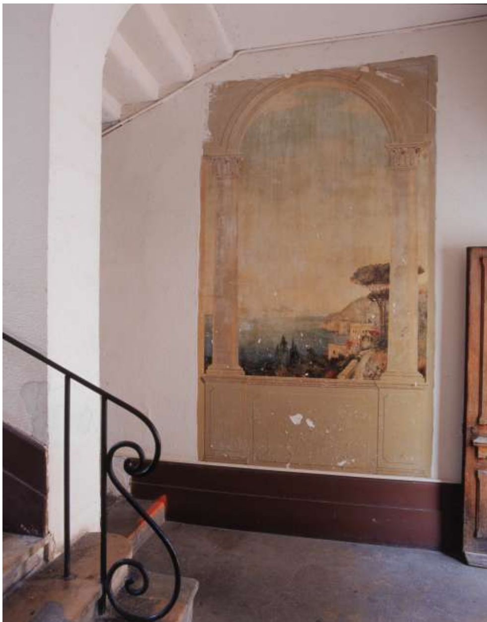
Vestibule : détail de la peinture murale.
