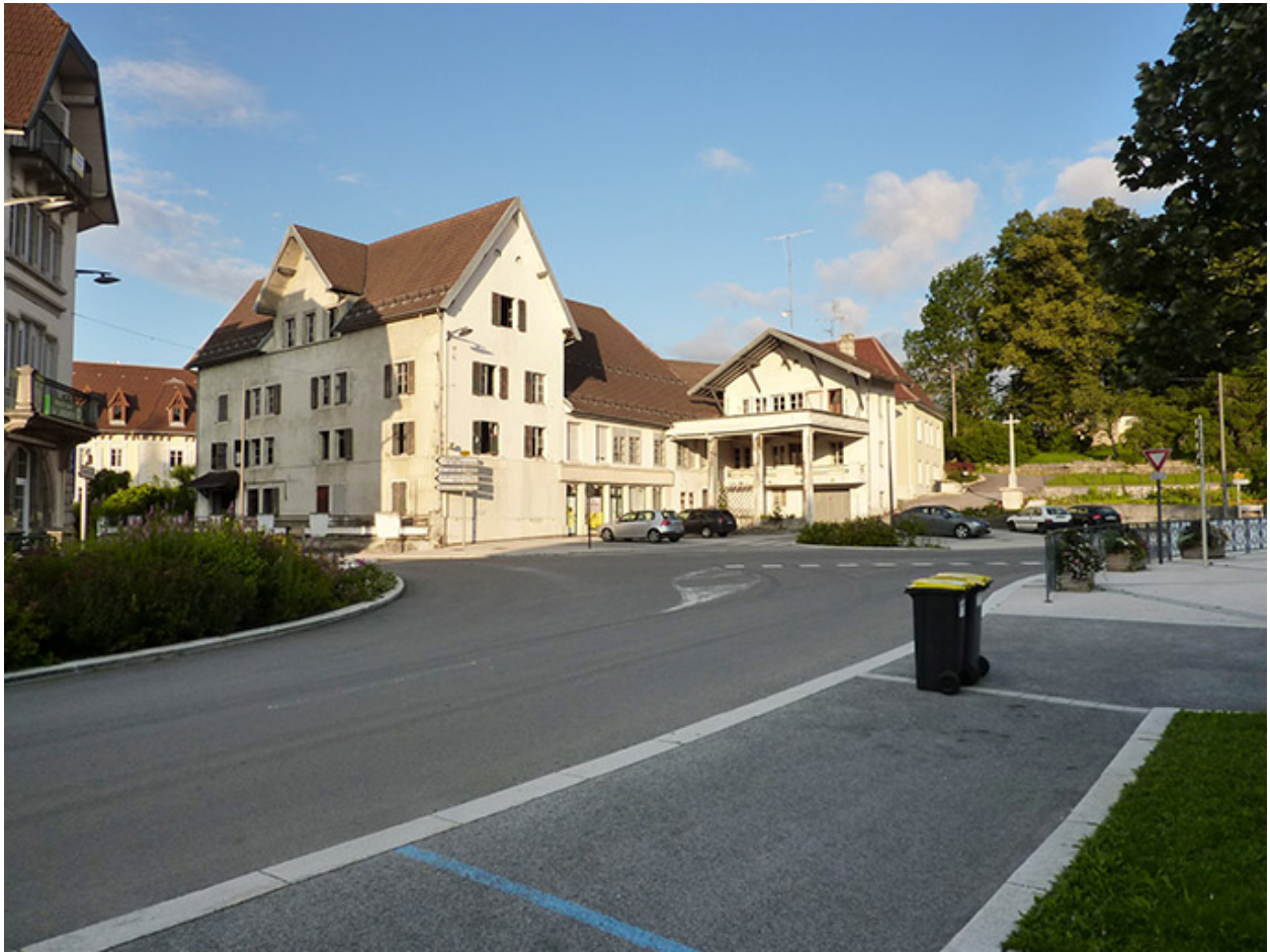
Vue d'ensemble depuis le nord-est, 17 juillet 2012.
