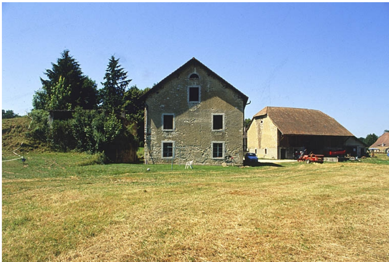
Mur-pignon nord du moulin.
