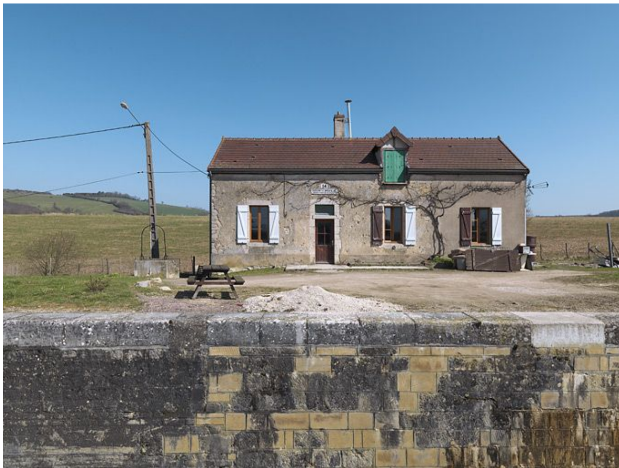
La maison éclusière de face. Puits.
