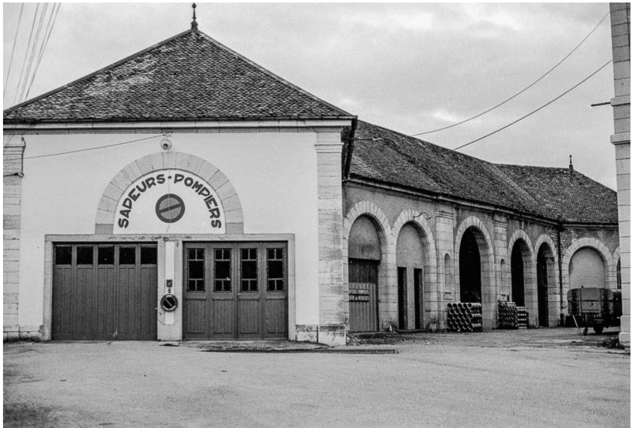
Vue des parties constituantes en 1975 : remise sapeurs-pompiers.
