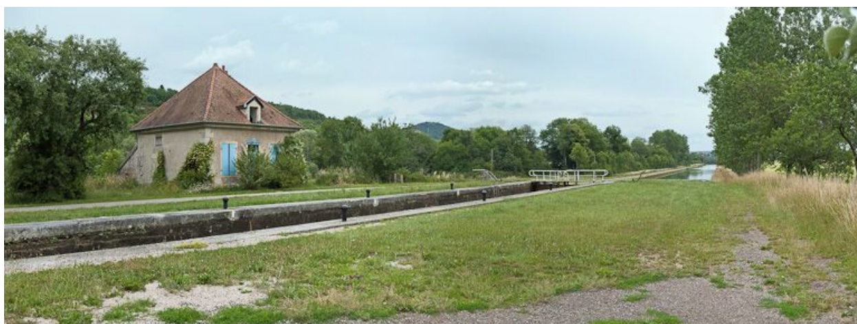
Vue d'ensemble du site d'écluse.
