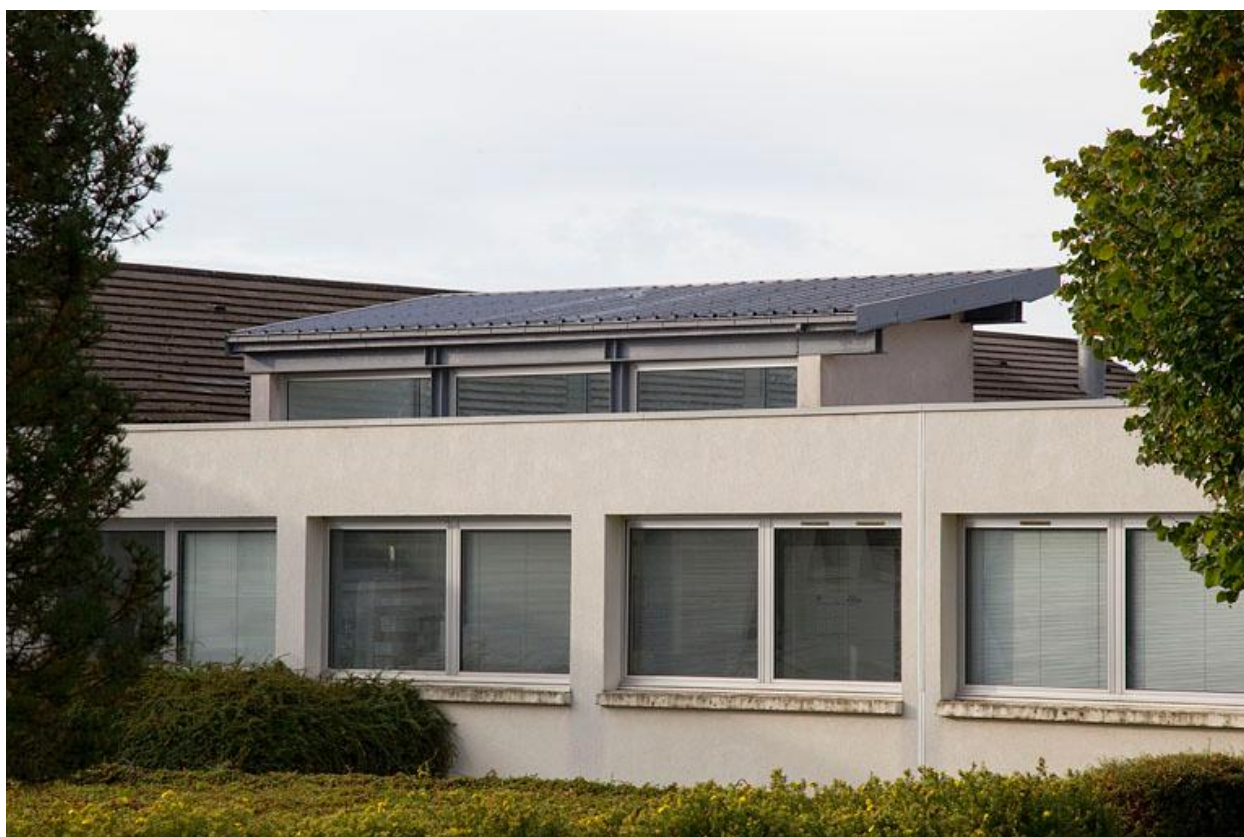
Lanterneau sur l'extension nord.
