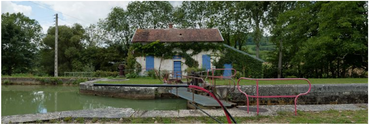
Vue de face de la maison éclusière.
