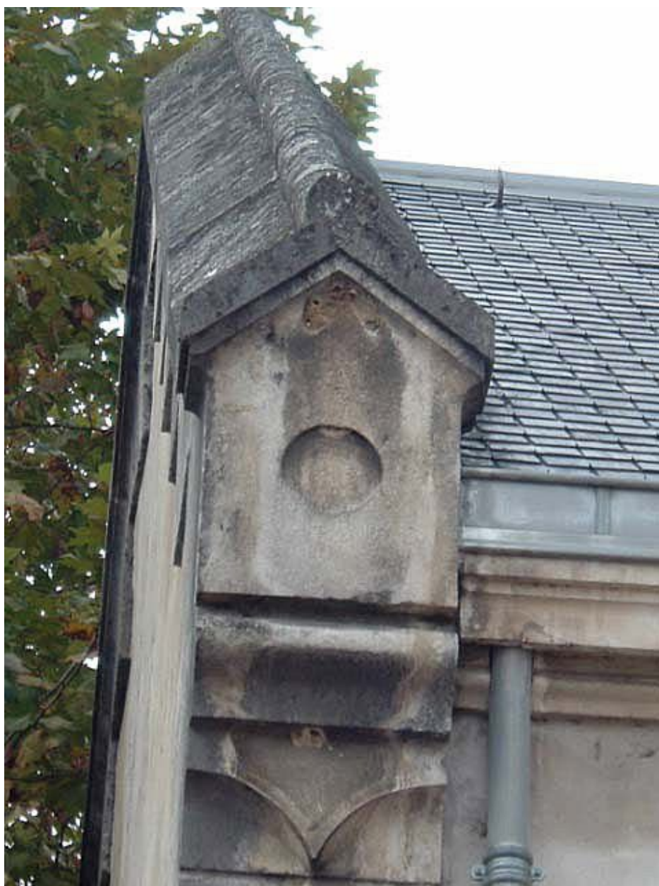
Vue de détail : rampant du pignon découvert.
