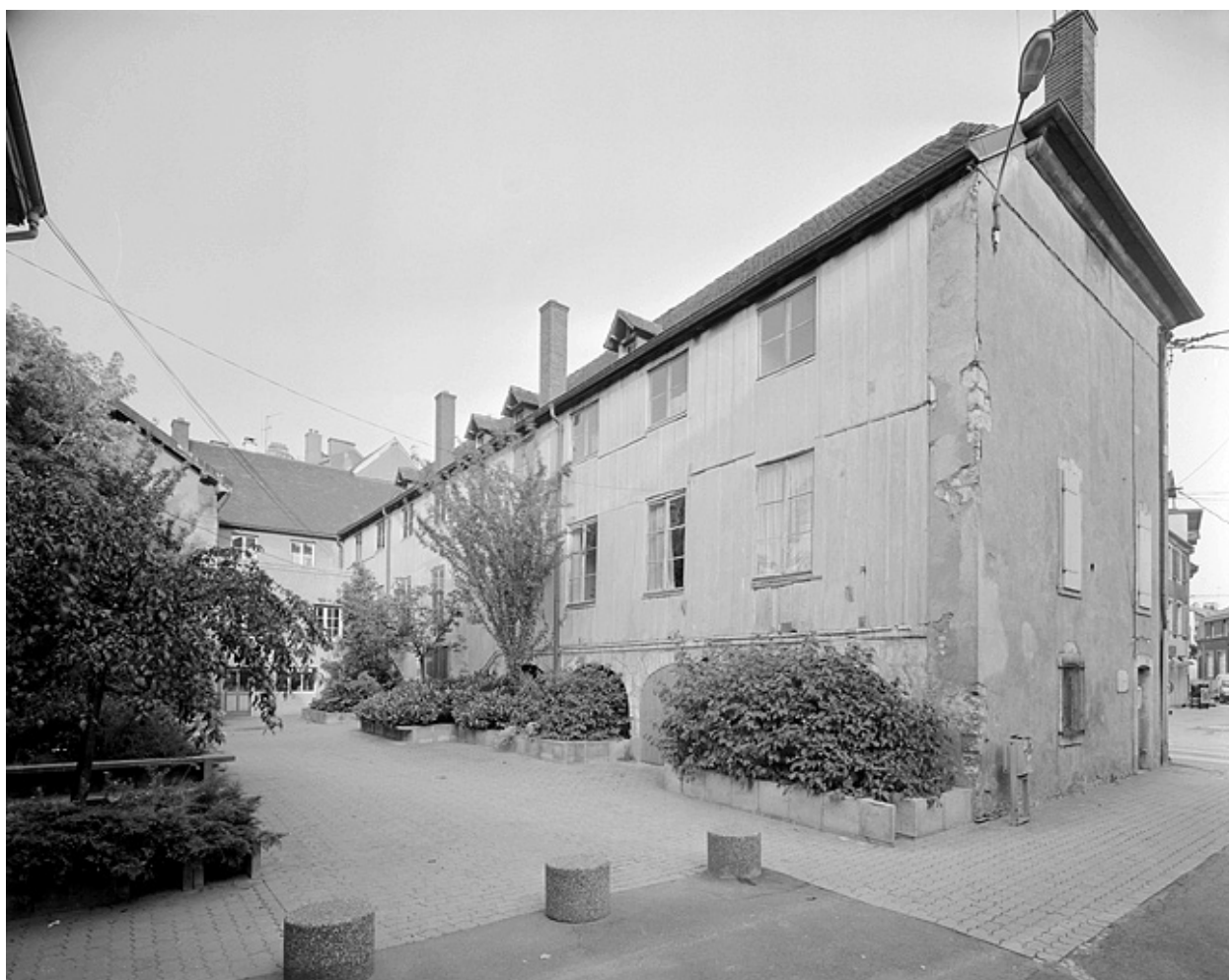
Façade sur cour.
