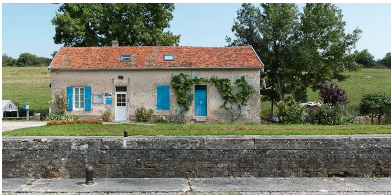
Vue de face de la maison éclusière.
